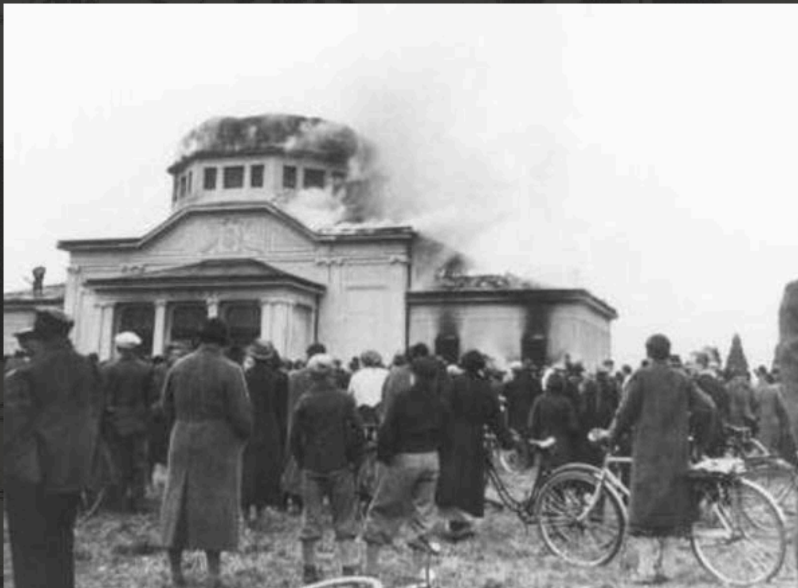
INCENDIO DELLA SALA CERIMONIALE DEL CIMITERO EBRAICO DI GRAZ, NOVEMBRE 1938
